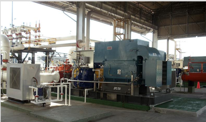
Instalación y puesta en servicio de motores de 3000 HP de las unidades de bombeo BPC 704 y BPC 705 de la estación Vasconia II, Ecopetrol Puerto Boyacá
